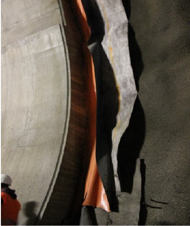
Práce na sekundárnom ostení tunela
